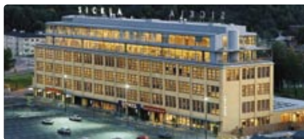
2001 Kvarteret Luftverkstaden, Sickla
